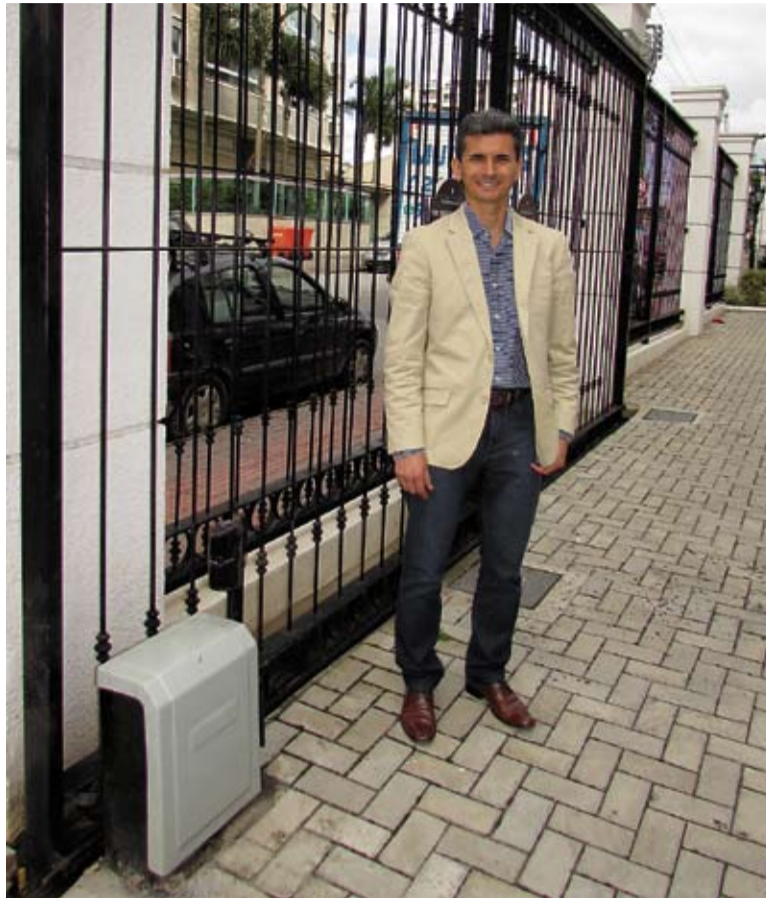
No condomínio Boulevard Neoville, o síndico Sidnei Garcia, trocou o portão manual por um automático há dois anos
