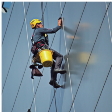
A LIMPEZA DE VIDROS externos de edifícios realizada acima de dois metros de altura exige qualificação técnica
