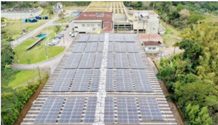
PAINÉIS instalados na ETA José Pedro Horstmann
