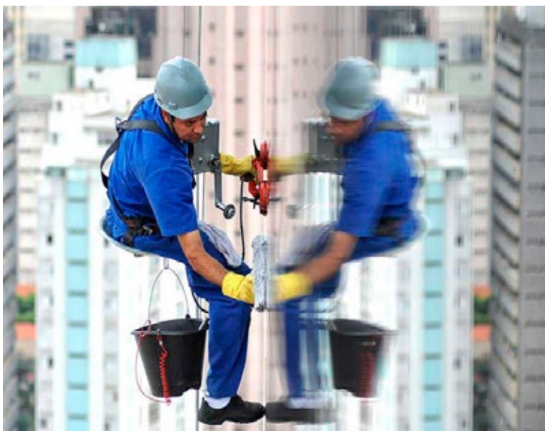
EM OBRAS de restauração de fachada, a exigência da ART é obrigatória
