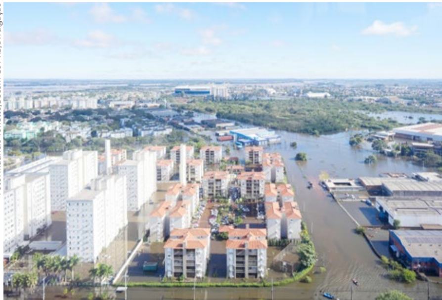
FOTO AÉREA mostra condomínios alagados por conta do aumento do nível do Guaíba na região metropolitana de Porto Alegre
