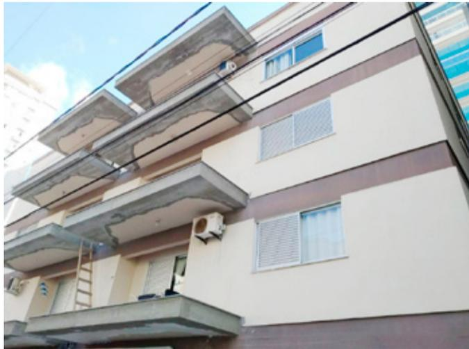
**OBRAS DE AMPLIAÇÃO DE SACADA** exigem conhecimento do projeto original para saber se a estrutura do prédio suporta a carga adicional
