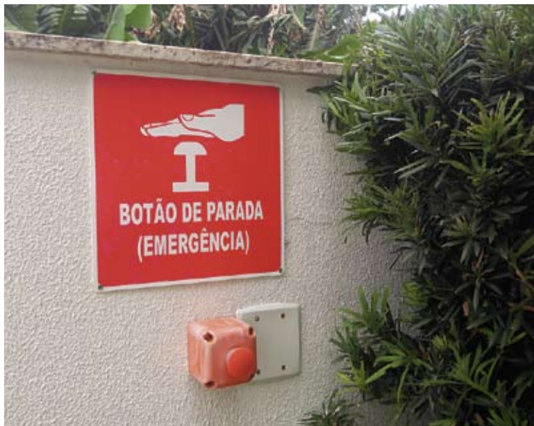
Botão de emergência para desligamento da bomba de sucção da piscina
