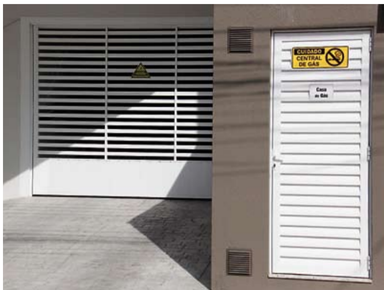
A estação para receber o gás canalizado é pequena, ao contrário dos espaços utilizados para abrigar os cilindros de GLP
