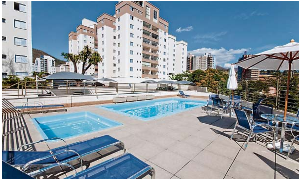
Uma das exigências para a segurança nas piscinas é a colocação de grade, cerca ou gradil que impeça a entrada de crianças desacompanhadas
