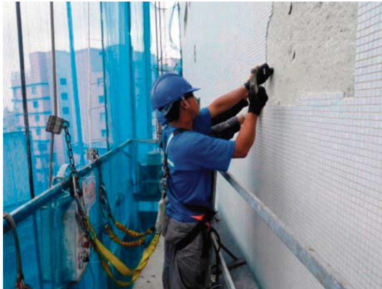
Os revestimentos devem passar por vistorias: som cavo, ondulações ou destacamentos indicam perda de aderência
