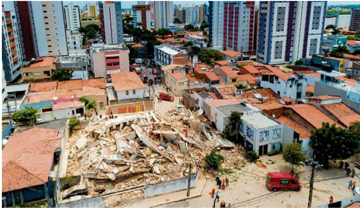
Desabamento do edifício Andrea causou a morte de nove pessoas, em Fortaleza
