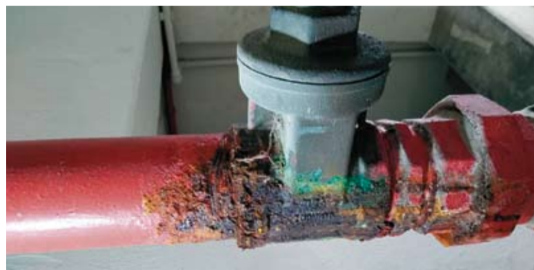
Tubulação de incêndio com ferrugem pela falta de manutenção
